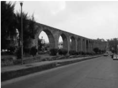
Imagen-13 Acueducto los Arcos de los Remedios.
