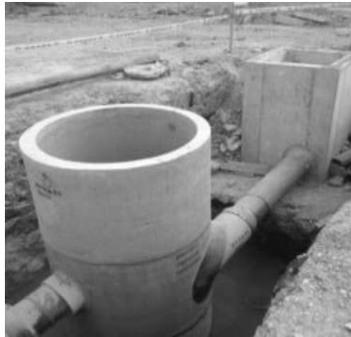
**Estructura externa de sedimentado**
