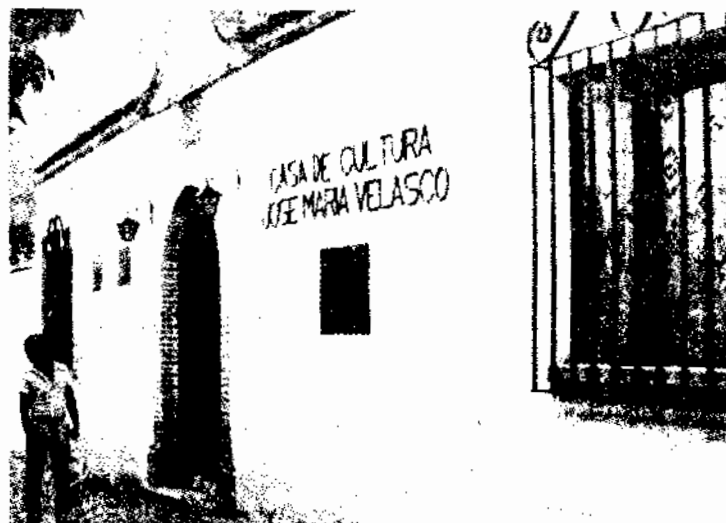
En la casa habitación de quien fue hijo ilustre del municipio de Temascalcingo, se encuentra instalada la Casa de Cultura "José María Velasco".
