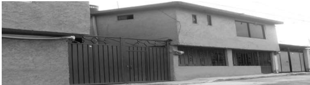
Imagen 9. Vivienda de autoconstrucción urbana media.
