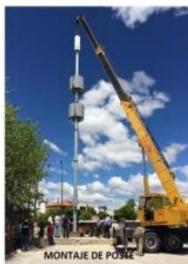
MONTAJE DE POSTE
